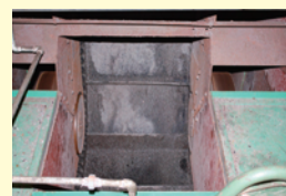
碎物搬送コンベア更新工事 2,416万円 （粗大ごみ処理施設）
