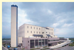
ごみ焼却処理施設・粗大ごみ 処理施設修繕（OH）工事 1億3,697万円
