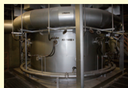
3号炉ガス冷却室更新工事 5,249万円 （ごみ焼却処理施設）
