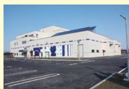
リサイクルセンター建設工事 12億2,433万円 （本体工事費）
