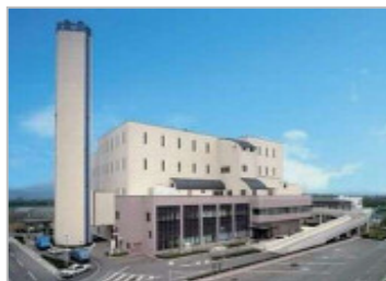
② ごみ焼却処理施設
