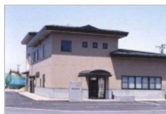
⑥ 下釜最終処分場 (下釜浸出水処理施設)
