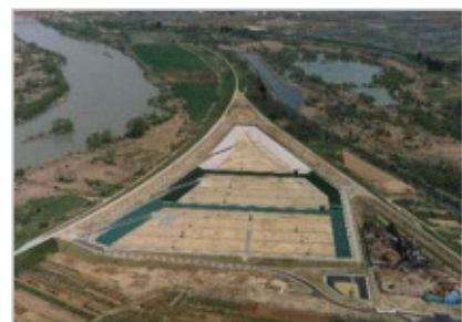
⑥ 下釜最終処分場
